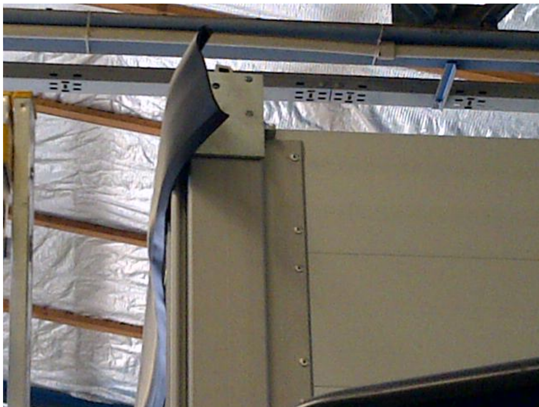
Přední horní montážní sada, nasazená, čelní pohled
